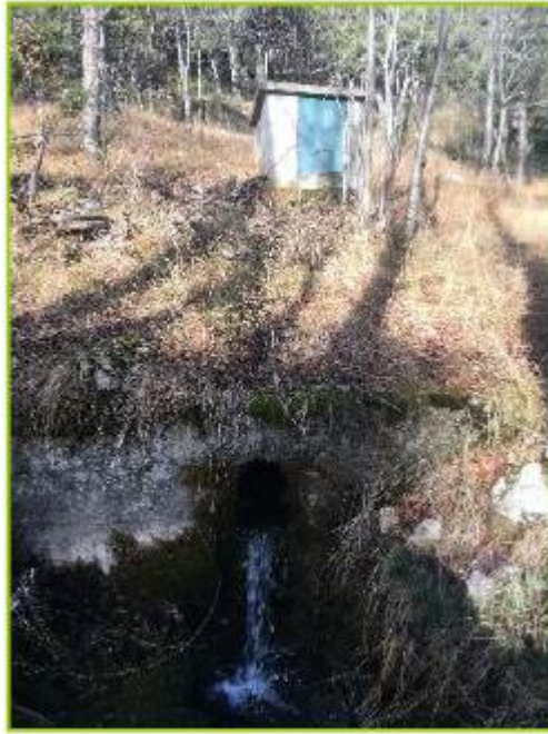
Photo 2 : évacuation du trop-plein dans le talus
